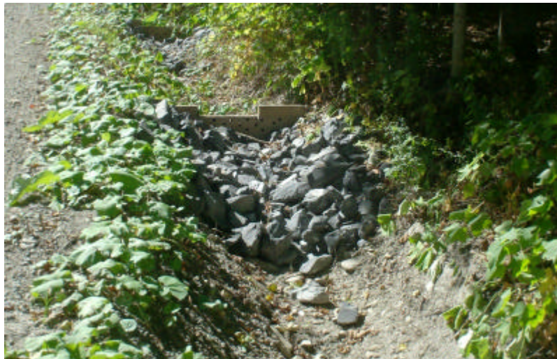
Exemple de trappe à sédiments. Photo : Ville Lac Brome, 2008.
